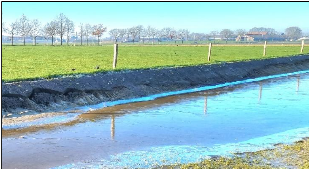
Foto van de aanleg van de ecologische zone in 2021–2022 met het profiel van de oorspronkelijke Ouwbeek. (Foto: Stichting Kasteel van Wouw)
