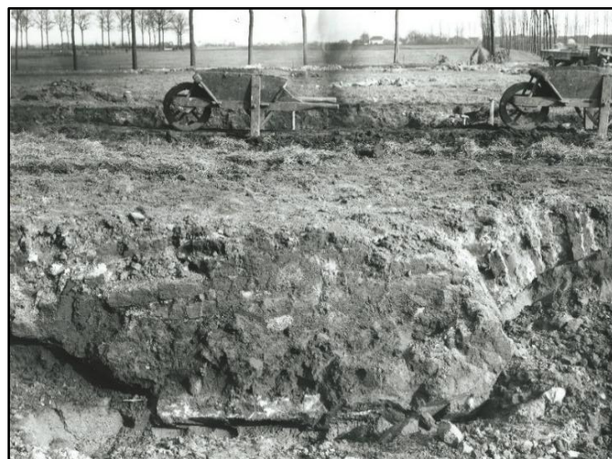
Details van foto's uit 1934 waarop het afgraven van de motteheuvel goed zichtbaar is. Op de onderste foto is te zien dat het maaiveld in die tijd ter hoogte van de onderzijde van de fundaties lag (RCE, 14.008, 14.013, 14.014).
